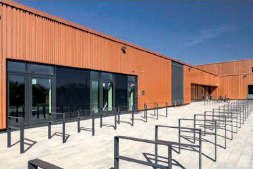
Fahrrad-Stellplätze direkt am Haus, rechts hinten der Eingang
