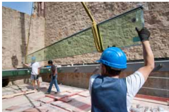
Montage der Glasträger in der Turmruine
