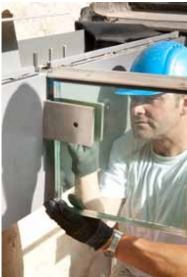
Bei der Montage der Glasträger war Augenmaß gefragt
