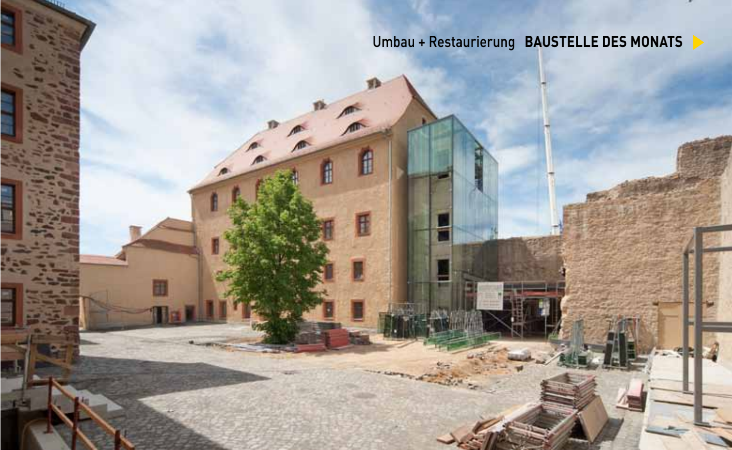
Das sanierte und sehr transparente mit viel Glas erweiterte Schloss Grimma kurz vor Abschluss der Bauarbeiten
