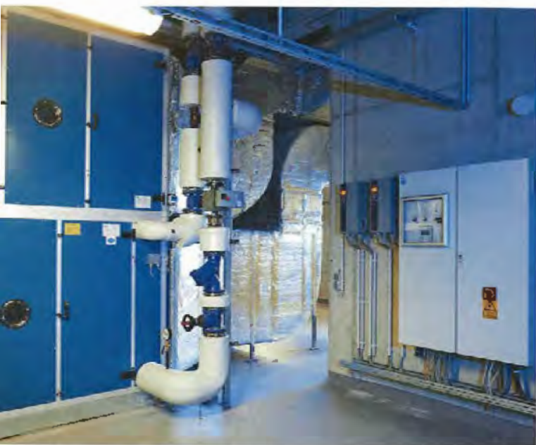
▲ Lüftungsgerät Schwimmhalle
