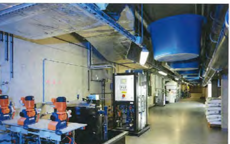
▲ Leinenabwurfbehälter oben unter der Decke und Membranelektrolyse (links)
