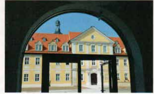
Clara-Wieck-Gymnasium im Denkmal Schloss Plauitz (Sanierung und Erweiterung), Bauherr: Stadt Zwickau, Liegenschafts- und Hochbauamt, Architekturbüro: THAUTARCHITEKTEN, Zwickau, Freiraumplanung: Sabine Kaiser Ingenieurbüro für Tiefbau Zwickau, ARC Architektur Concept Pfaffhausen + Staudte GbR, Zwickau, Foto: Helmut Pfefferkorn
