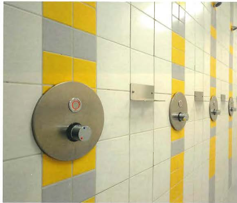
▼ Selbstschlussarmaturen
