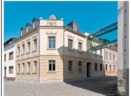
Im Vergleich zum Original wurde das Kontorgebäude gut rekonstruiert. Unterschiede sind die größeren Gauben sowie der Glasübergang.
