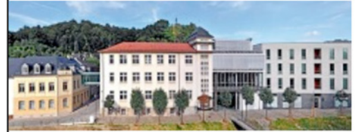
Von links nach recht: Kontorgebäude, gläserner Übergang, ehemalige Strickwarenfabrik sowie der Neubau an der Bachgasse.
