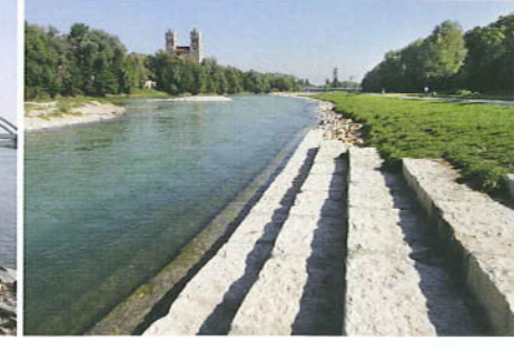
20 In München gehen im kommenden Jahr die Arbeiten am Umbau der Isar zu Ende. Ein besserer Hochwasserschutz ist eines der drei Ziele des Isarplans.
