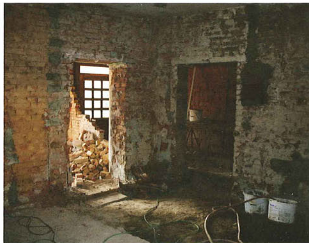
▲ Entkernung des Erdgeschosses
